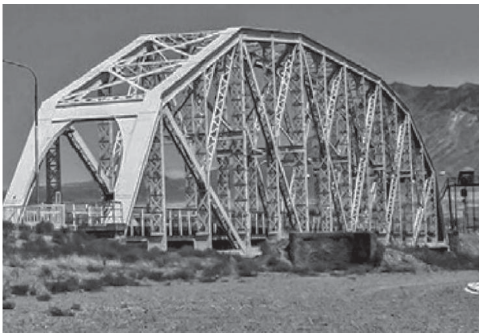
Мост через Аракс в г. Джульфа. Построен в 1907 г.
