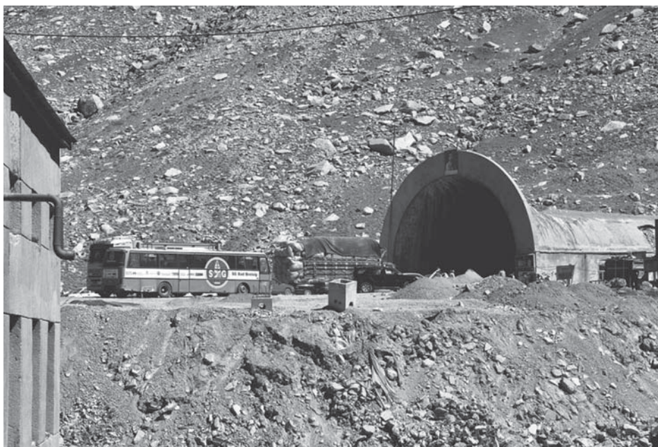
Тоннель Саланг, сооружённый советскими метростроителями
